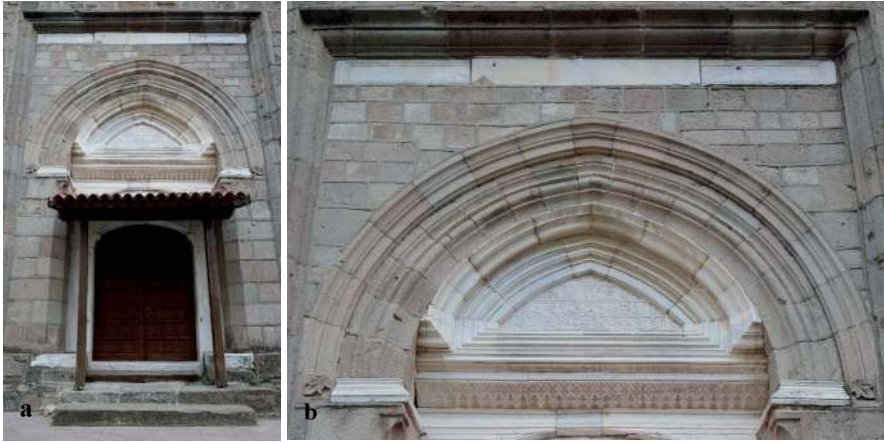
Fotoğraf 3a: Bergama Ulu Camii'nin kuzey cephesindeki taç kapısı. Fotoğraf 3b: Taç kapı kemeri detayı.
