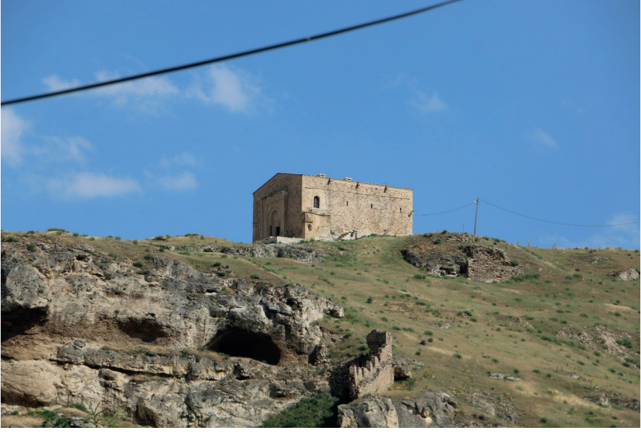
Görsel 1. Divriği Kale Camii Genel Görünüm
