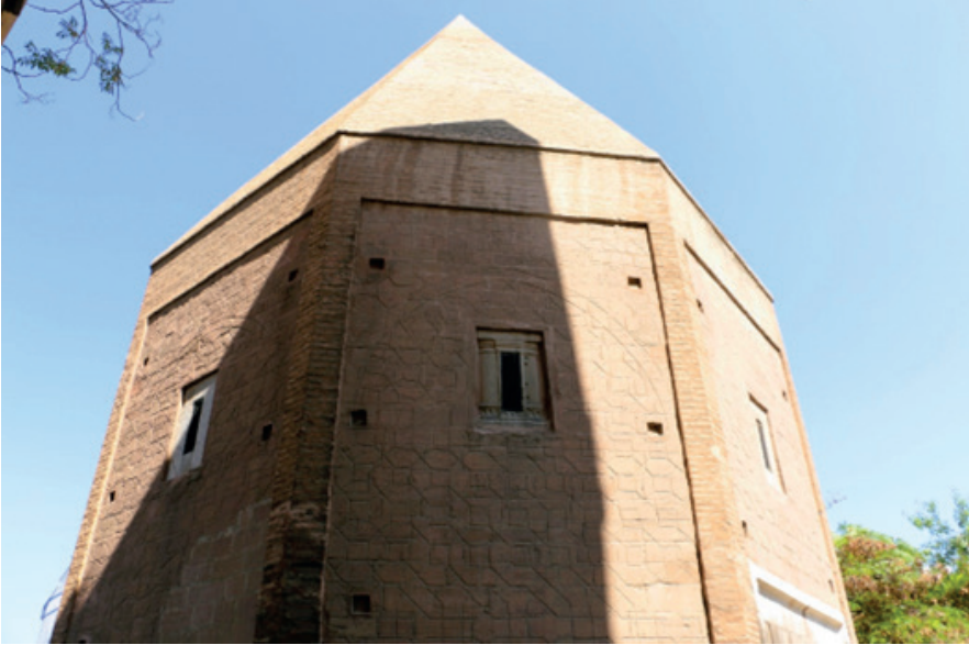
Görsel 34. Konya Seyfeddin Karasungur Türbesi Cephe Düzenlemesi
