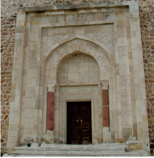
Görsel 6. Divriği Kale Camii Taçkapısı
