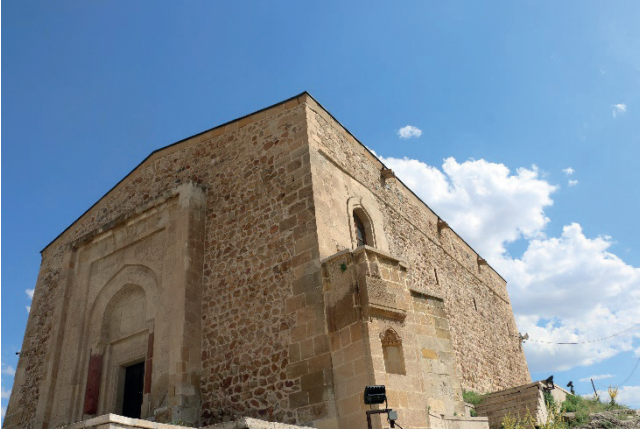
Görsel 2. Divriği Kale Camii Kuzey Cephesi ve Hünkar Mahfili Girişi
