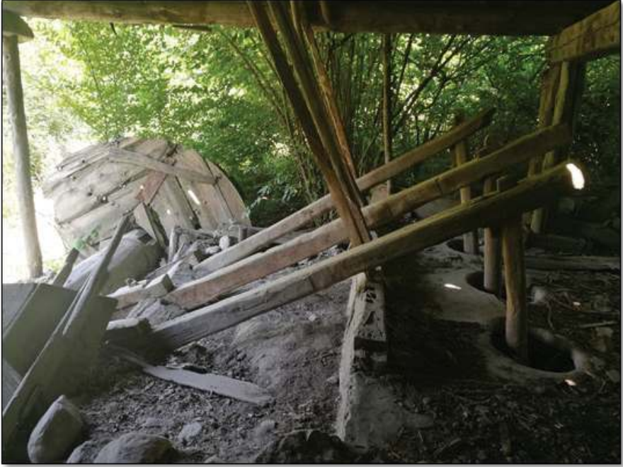
Şekil 4: Bulgur (Ding) Değirmeni 11 (Kuzyaka Köyü)
