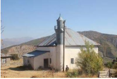
Foto 2: Batı cepheden görünüş
