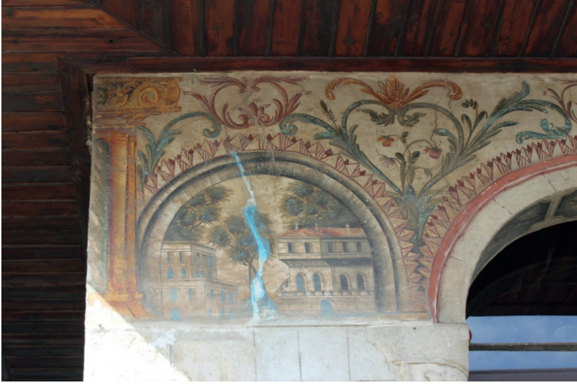
Görsel 4. Doğu yöndeki son cemaat yeri revaklarının dışa bakan yüzündeki duvar resmi (Aysu Ateş Özkan).
