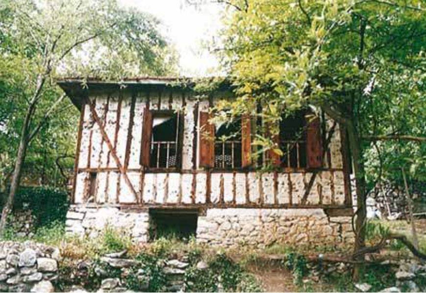
Fotoğraf 12. Güdüllü Evi. Bahçede havuz odası dıştan görünüm.
