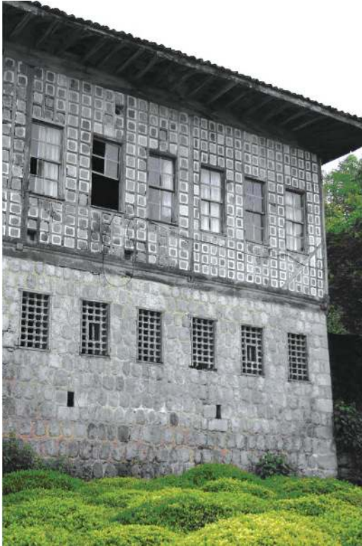
Resim 6. Fındıklı, Çağlayan Köyü, Şevketbeyoğlu Konağı, Rize
