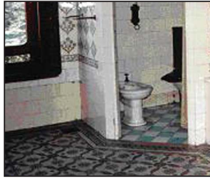
Resim 18: Beylerbeyi Sarayı'nda modernleşme/ batılılaşma etkisiyle sultan banyosu küvet ve alafrağa tuvaleti. Fotoğraf: Deniz Demirarslan
