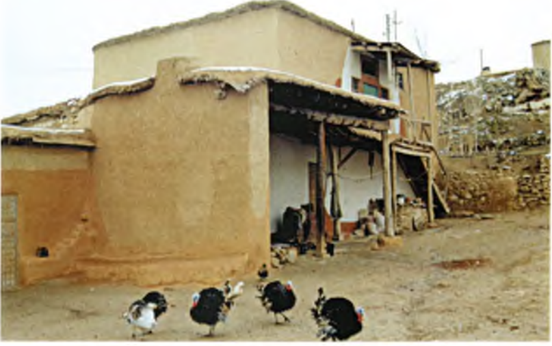
Resim 14. Sarayönü Gözlü Kasabası Adil Koca Evi genel görünüşü
