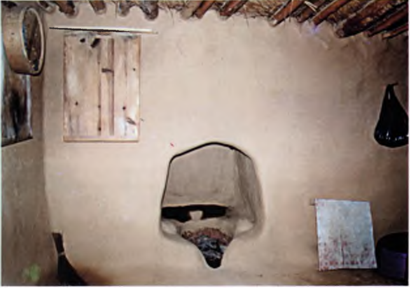
Resim 12. Kazım Süslü Evi'nin aşhanesi büyük ocağı
